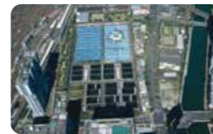
高輪ゲートウェイ駅の裏にある広大な芝浦水再生センター
