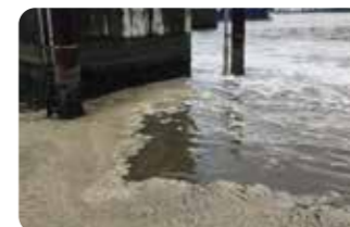
未浄化汚水の排水口
