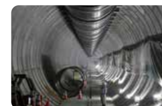
3kmまで貫通した直径6mの圧送管(参考画像)
